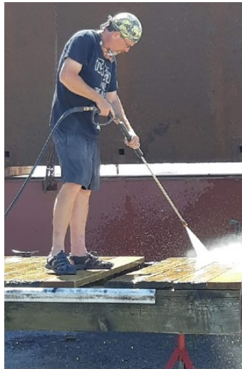
Mark à laver sous pression le quai (24 juin)
