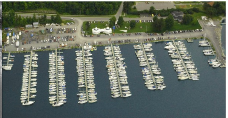
Collins Bay Marina - maintenant
